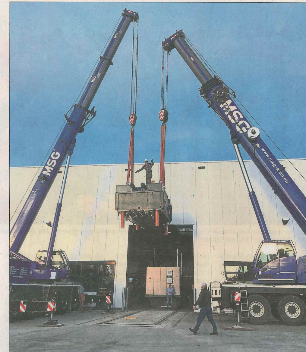
Zwei Kräne haben die Maschine am Haken, die gleich auf einen Tieflader herabgelassen wird.
