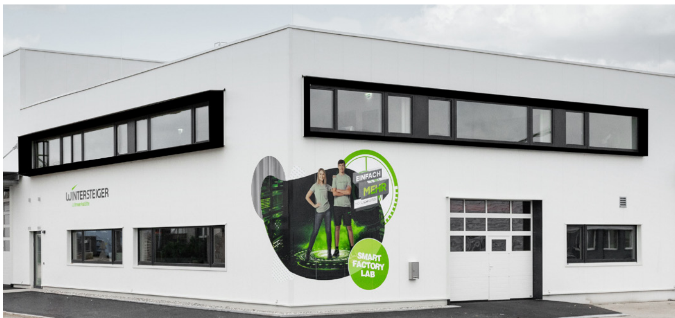
Neubau 2022: Neue Lehrwerkstätte „Smart Factory Lab“
